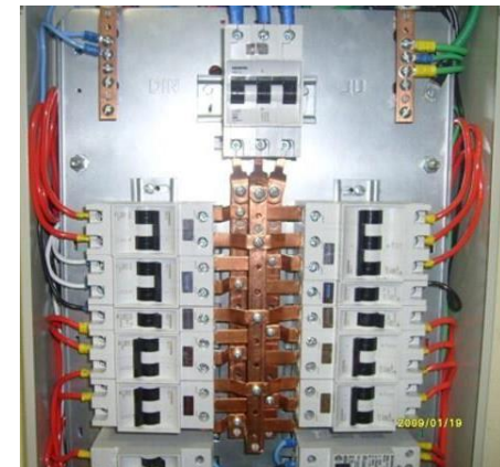
Esquema de ligação em quadro de distribuição (6.4.3.4.4)
