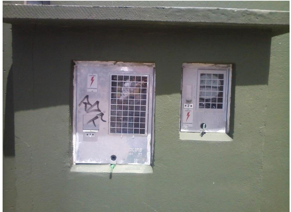
No mesmo poste, com caixa incorporada, e em mureta, muro ou parede se pode ter até três consumidores monofásicos ou um monofásico e um bifásico.
