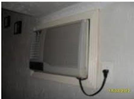
Apenas um aparelho por circuito, então, alimentação através de tomada com proteção geral no quadro de distribuição
