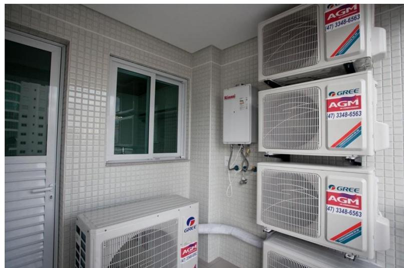
As condensadoras podem ter uma ou mais evaporadoras ligadas, dependendo do modelo/fabricante (Multi-Split).
