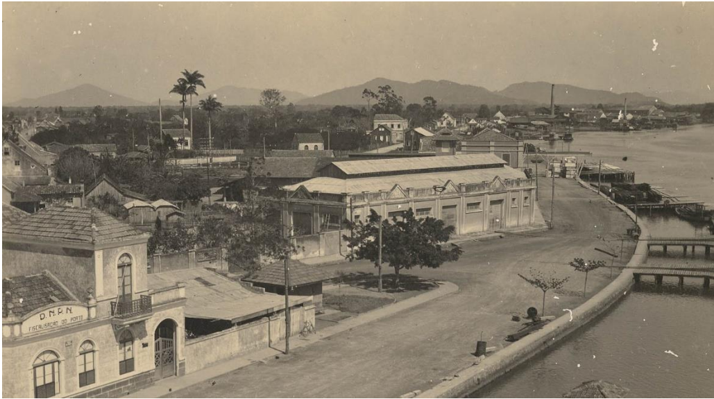
Figura 16 – Antiga Fiscalização do Porto com visto para o rio Itajaí-Açu
