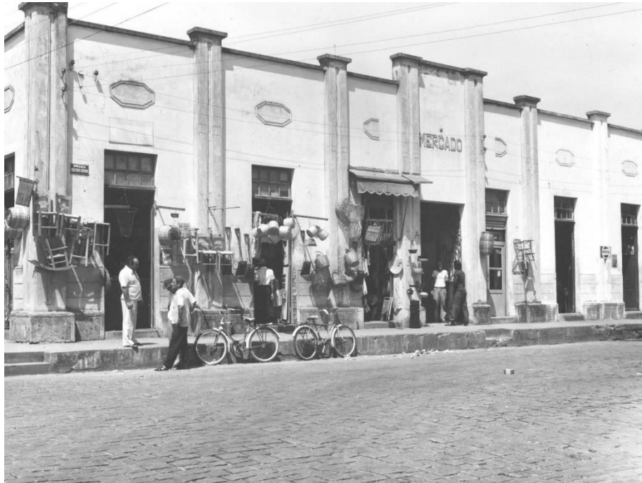
Figura 06 – Arquitetura atual do prédio do Mercado Público Municipal
