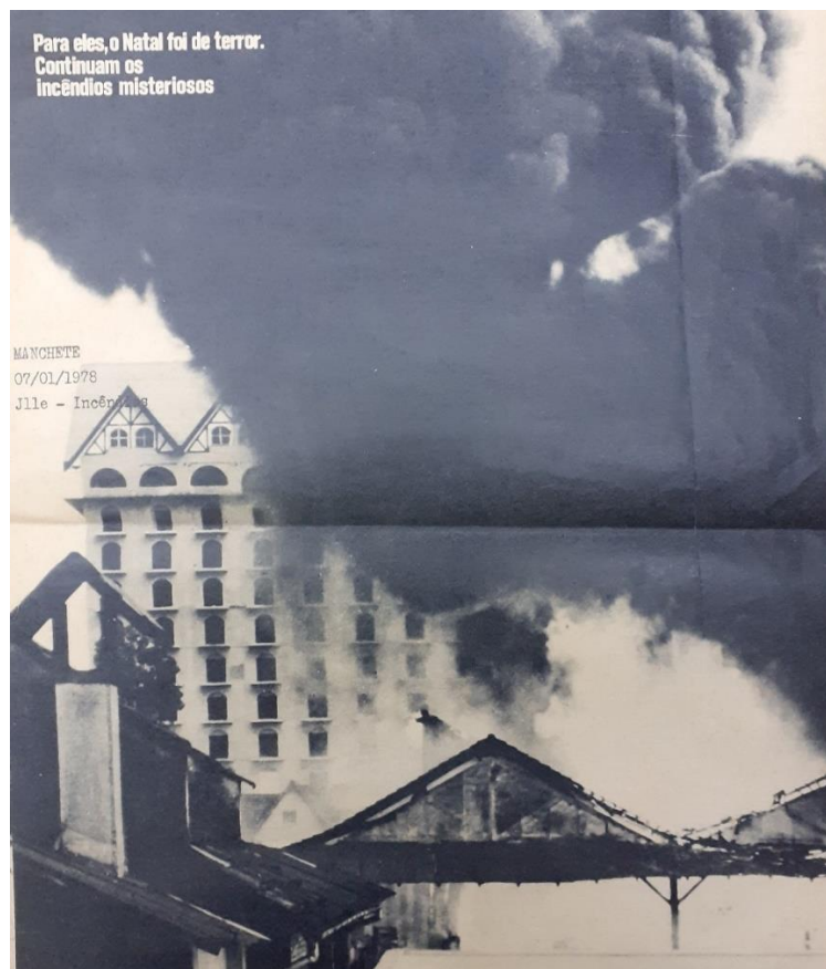
Figura 18 - Incêndio no Hotel Tannehoff
