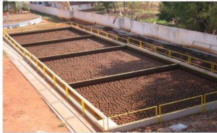
Figura 5- Leito Secagem de resíduo de Estação de Tratamento de Água
