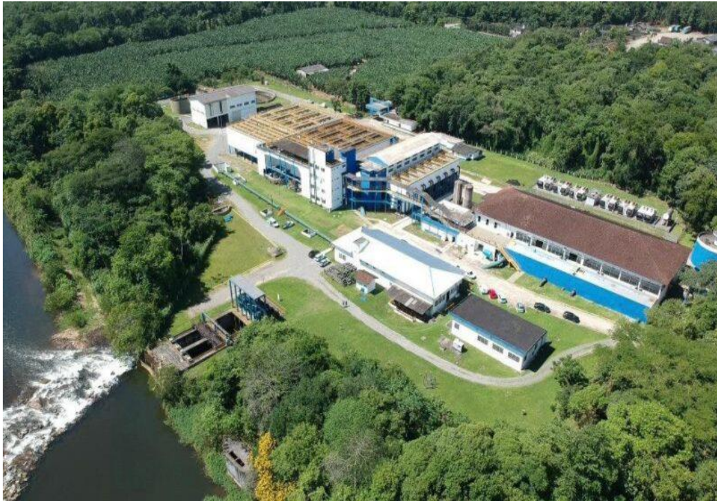
Figura 11 – ETA Cubatão da Companhia Águas de Joinville
