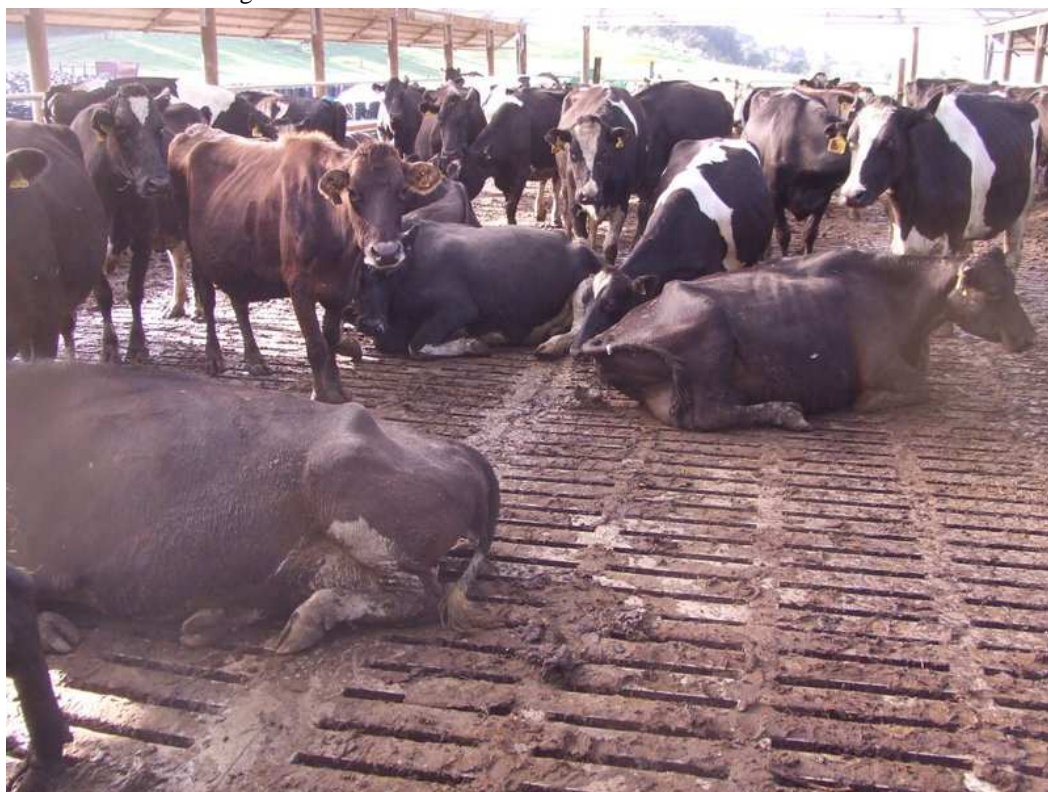
Figura 15 - Piso de concreto vazado das Casas de rebanho.
