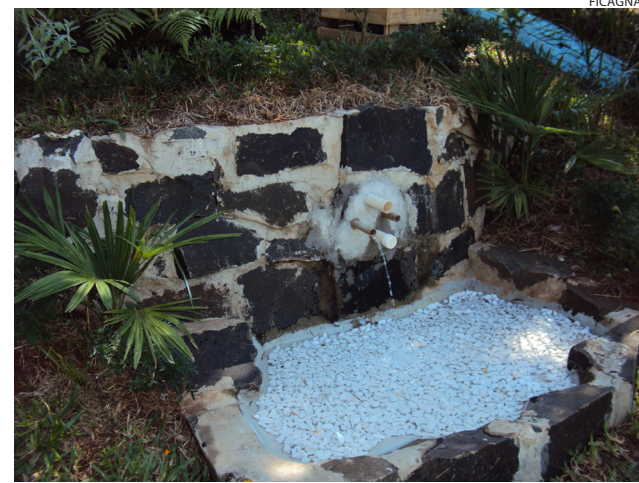
Fonte protegida Modelo Caxambu do CDA 2011 – Campo Demonstrativo Alfa Cooperalfa/Chapecó
