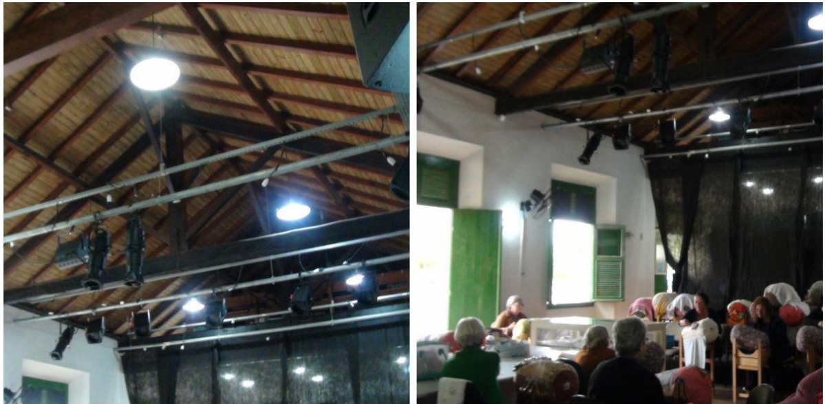
Figura 20 - Estrutura Casa das Máquinas
